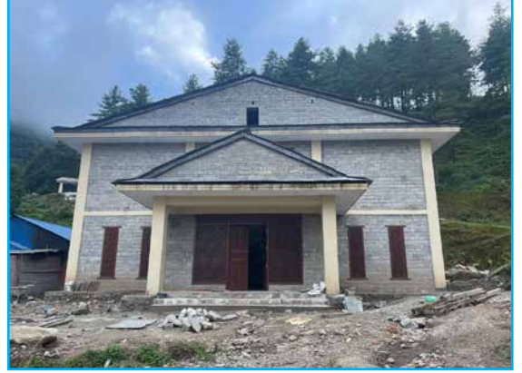
थामी संग्रहालय मूख्य भवन, भीनपा - १
