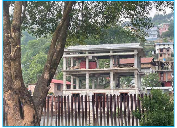
निर्माणाधिन २ नं वडा कार्यालय भवन , भीनपा - २
