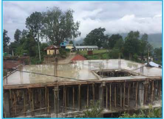
निर्माणाधिन ५ नं वडा कार्यालय भवन, भीनपा - ५
